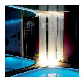
Ein dreifach segmentierter Lichtvorhang mit einer Länge von 4 m wurde zur Wandgestaltung in einer privaten Schwimmhalle eingebaut. Die hierdurch erzielte Lichtintensität dient der stimmungsvollen Raumbeleuchtung. Durch die Ausstattung der Lichtprojektoren mit DMX-Modulen, können weitere im Raum platzierte Lichtinstallationen synchronisiert werden.
